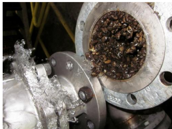
Figura 40. Canonada industrial infestada de musclo zebra. Font: essemaq.com
