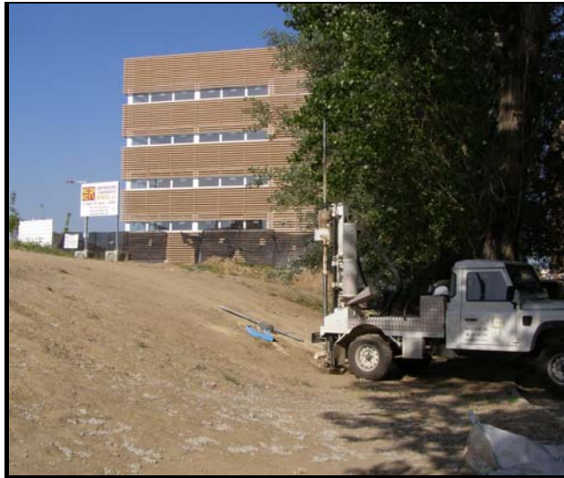
■ ZONA RECONEGUDA : Emplaçament del sondeig rotacional S1.
