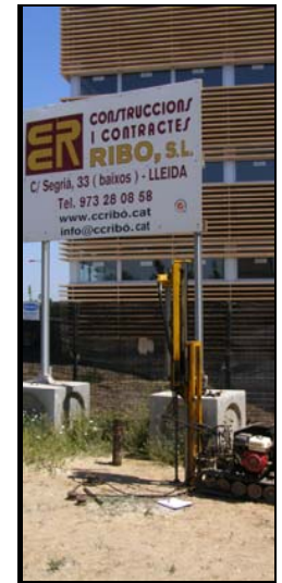
■ Vista de la zona reconeguda; emplaçament i execució del sondeig S2.
