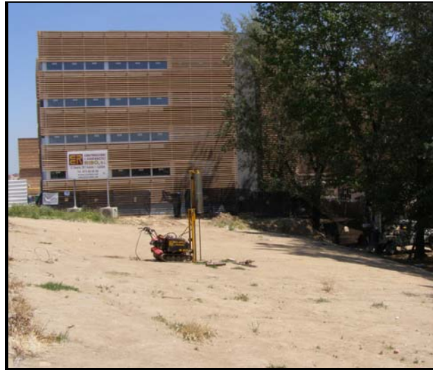
■ Vista de la zona; emplaçament i execució del sondeig DPSH-2.
