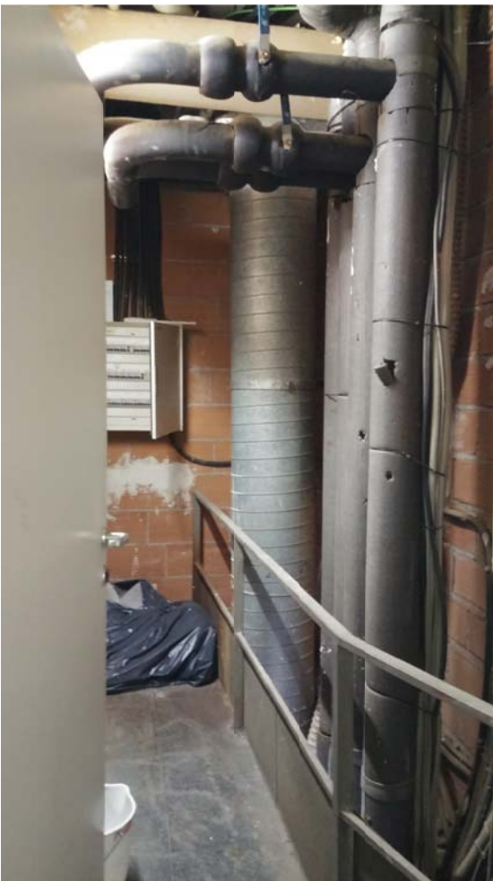
MUNTANT DE FRED A DESMUNTAR I REALITZAR LES CONNEXIONS A LES CANONADES ACTUALS, DE LES VALVULES CAP A DISTRIBUCIÓ QUEDA IGUAL
