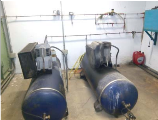
COMPRESSOR D'AIRE A DESMUNTAR
