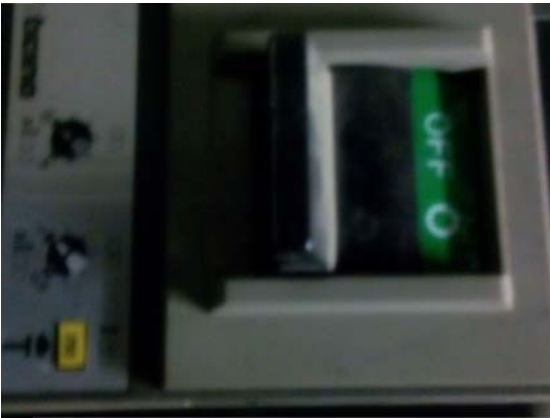
PROTECCIÓ 250A SITUADA EN PLANTA SOTERRANI A APROFITAR PER CONNECTAR LA NOVA REFREDADORA EN PLANTA TERCERA
