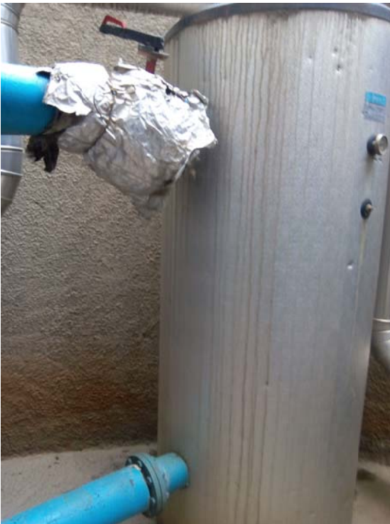
DIPÒSIT D'INÈRCIA PER APROFITAR, CAL DESMUNTAR, NETEJAR, PINTAR I SITUAR EN PLANTA TERCERA
