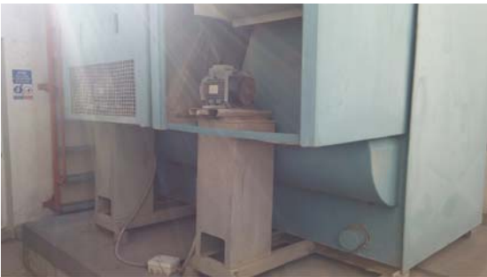
EVAPORADOR REFREDADORA DE PLANTA TERCERA A ELIMINAR
