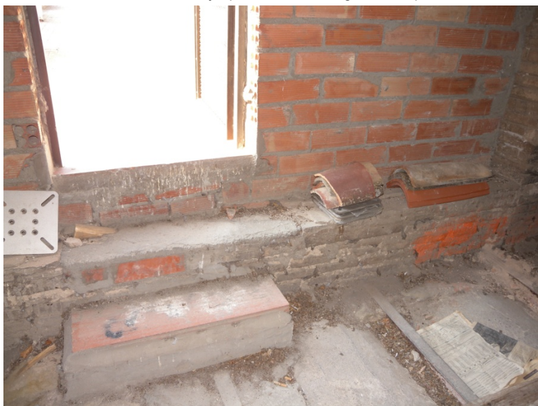
Secció A: Desnivell entre les dues crugies del forjat i identificació dels diferents materials i gruixos de la paret central de la planta sotacoberta
