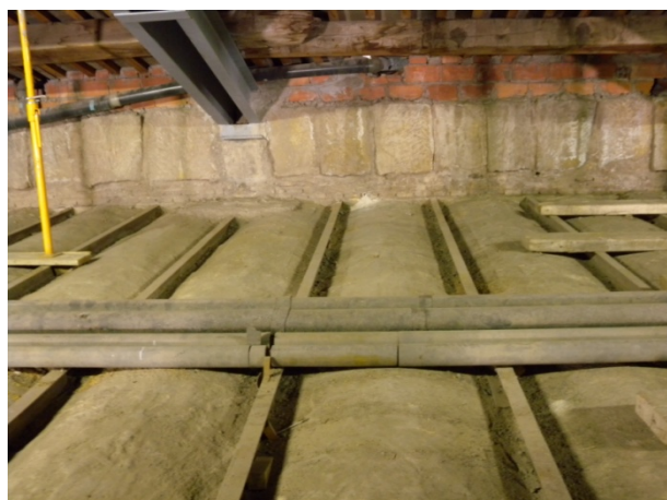
Secció B: Forjat format per biguetes metàl·liques i revoltó ceràmic
