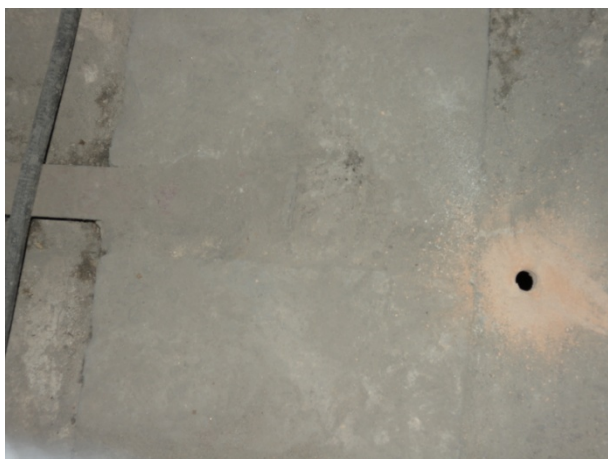
Secció B: Recolzament central en paret de pedra de 38cm de gruix. S'ha fet una perforació al costat per veure que el gruix del mur no canvia
