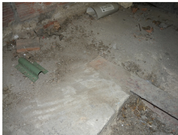
Secció C: Recolzament de les biguetes del forjat sobre un mur de pedra, amb un gruix aproximat de 60cm. El recolzament de la cruïja sotacoberta és d'uns 25cm
