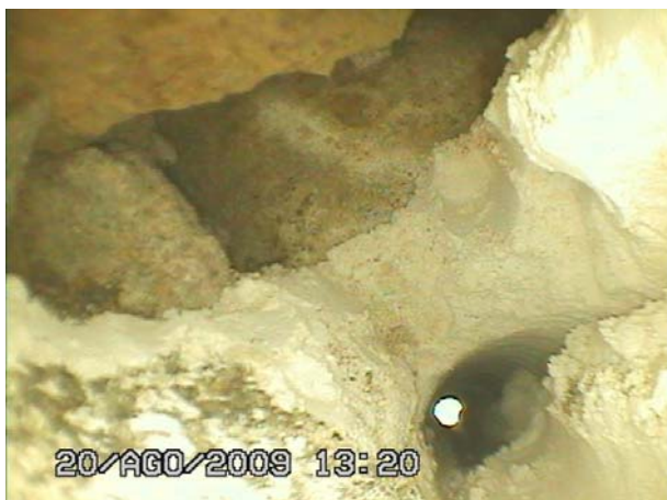
Secció C: A la part inferior, perforació efectuada i per sobre, heterogeneïtat de peces de pedra i maó massís per reomplir l'espai entre els carreus de pedra
