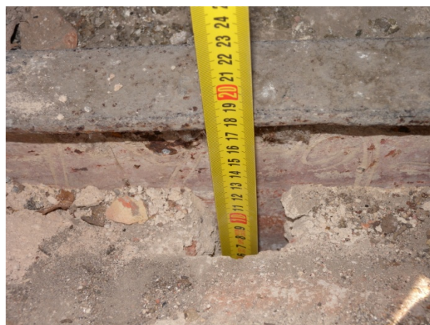
Cala al forjat. La bigueta té 18cm de gruix i el revoltó de maó de pla, uns 4cm.
