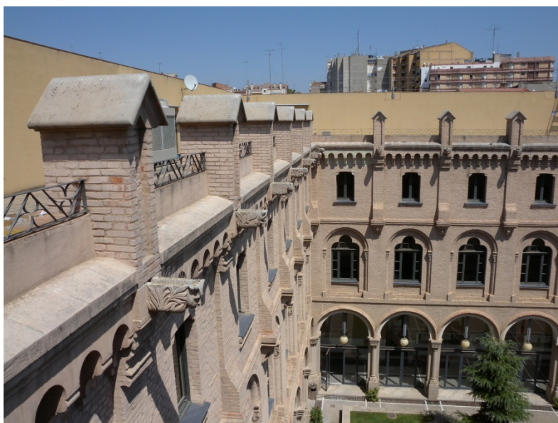
Claustre al costat del carrer Ramon i Cajal. Destaquen les gàrgoles que indiquen el pendent original de la terrassa. També es pot observar com tant la cara exterior de la façana com els pinacles entre les baranes són de maó massís.
