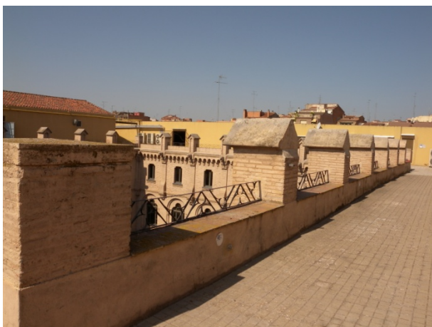
Terrassa del claustre de l'ala de Ramon i Cajal, amb paviment de panot de formigó. Es pot observar a simple vista el pendent cap a l'interior del claustre.
