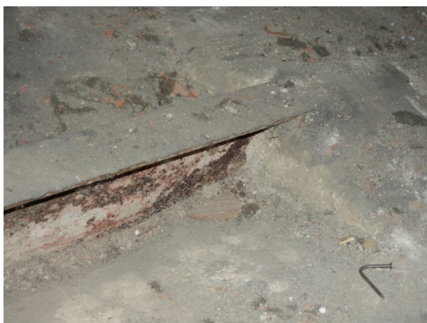
Secció C: Perfils metàl·lics del tram de forjat sotacoberta amb símptomes significatius d'oxidació i corrosió
