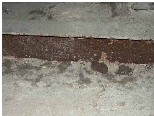
Secció C: Perfils metàl·lics del tram de forjat sotacoberta amb símptomes significatius d'oxidació i corrosió
