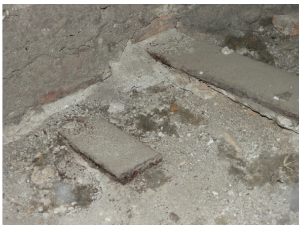
Secció B2 (ala dreta): El recolzament de les biguetes del forjat interior i exterior esta al mateix nivell, recolzades directament sobre mur de pedra
