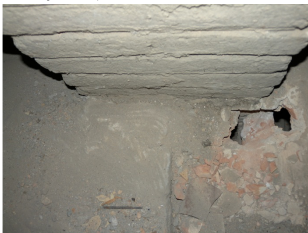
Secció B: Cala realitzada a l'ala esquerra de Rambla Aragó, on el recolzament és de paret de 19cm i al davant hi ha un envà de 5
