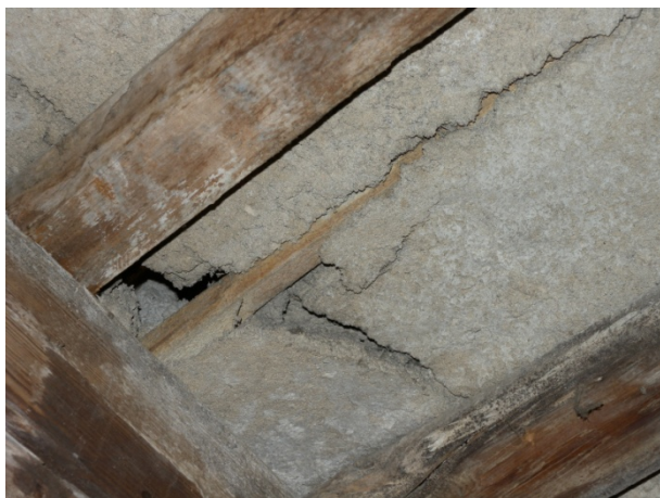
Panells esquarterats seguint la direcció dels llistons de fusta del seu interior
