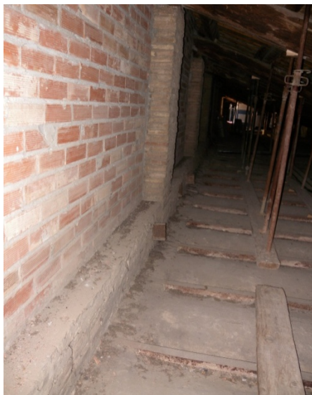
Secció A: Recolzament central de les dues crugies de forjat. Es pot observar el final del mur de pedra, la bancada de maó massís i la part superior de paret de totxana. Encerclat, punt on es va realitzar una cala al forjat per determinar el gruix i composició del revoltó
