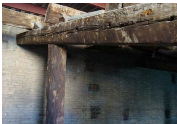
Atac de corc i clivells al cap A del cavall CE''
