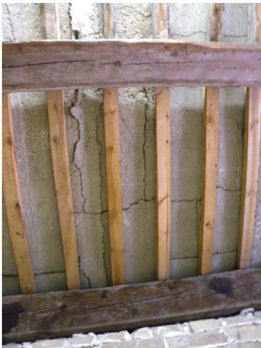
Sistema de suport de les teules de coberta amb un panell de morter alleugerit que es trenca i mou amb facilitat. A totes les ales de coberta inspeccionades de l'edifici es manifesta sovint aquesta patologia.
