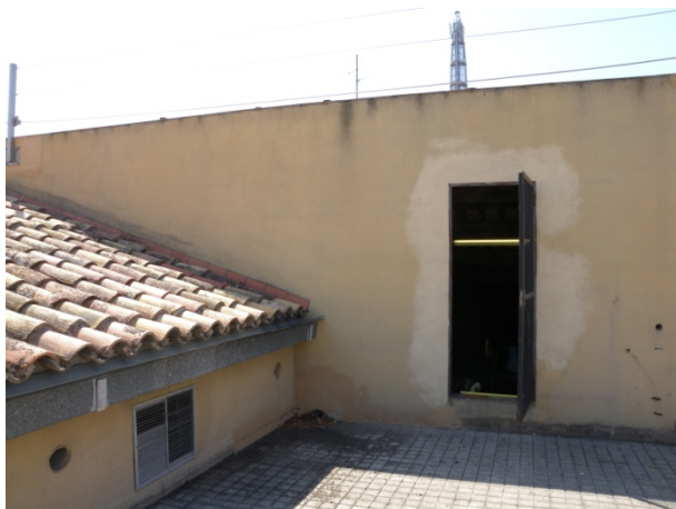
Secció C: Accés a l'ala de Bisbe Messeguer, amb desnivell interior – exterior d'uns 20cm. També s'observen taques d'humitat i una bunera, que indicarien la direcció d'evacuació de les aigües cap a l'interior de l'edifici
