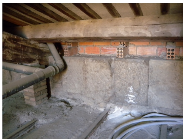
Secció C: Recolzament del forjat a la façana exterior, que coincideix amb la solució descrita de la secció A
