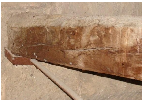
Clivelles amb profunditat de 5 centímetres en el cavall esquerre
