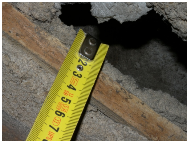
Panell trencat per on es pot veure la part inferior de la teula àrab. La distància entre els llistons de 20x20mm de l'interior del panell és d'uns 10cm, i el gruix total del panell d'uns 5cm.
