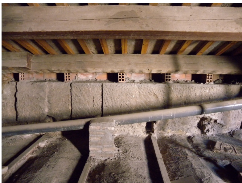
Secció C: Alçat de la zona de façana exterior on es poden observar forats on possiblement es van encastar perfils sobre el forjat existent
