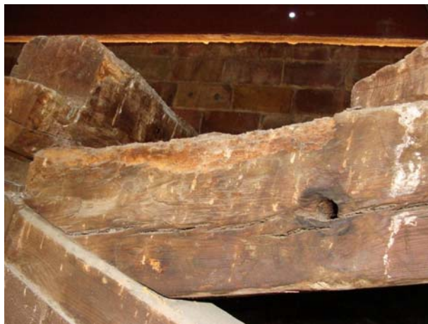
Aspecte humit i malmès del cap A del cavall CE''
