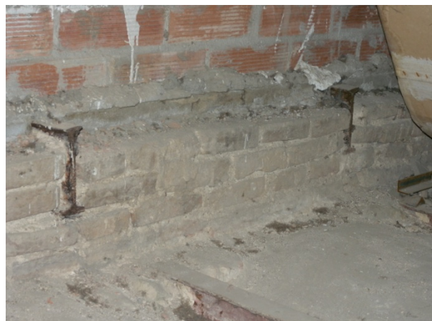
Secció B (ala esquerra): Recolzament de les biguetes del forjat de coberta plana sobre una bancada de maó massís, amb un desnivell de 30cm en relació al forjat interior, tal com succeïa a la secció A
