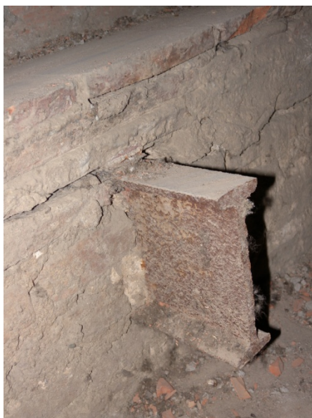
Secció A: Vista del cap de les biguetes de la terrassa del claustre, situades uns 30cm per sobre del forjat de sotacoberta. Sobre els perfils s'identifiquen diverses capes de rasilla que podrien haver format l'acabat original de la terrassa abans de la col·locació del panot.
