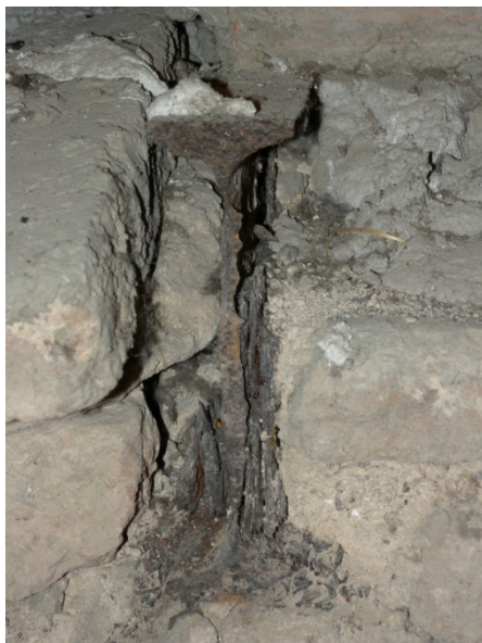
Secció B (ala esquerra): La majoria dels caps de les biguetes del forjat de la coberta plana presenten símptomes d'oxidació i corrosió rellevants, suposant en alguns casos una pèrdua significativa del gruix de l'ànima, que s'ha exfoliat
