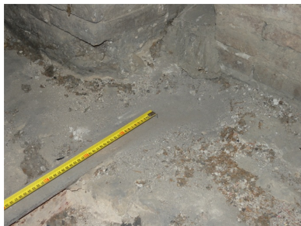
Secció B2 (ala dreta): El recolzament de les biguetes del forjat interior i exterior esta al mateix nivell, recolzades directament sobre mur de pedra
