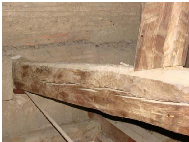
Clivells laterals de 7 centímetres al cavall CE
