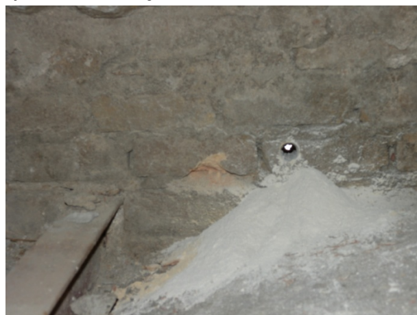
Perforació efectuada a la façana de Rambla Aragó. La pols dels primers 25cm és rogenca, corresponent a obra de fàbrica, i posteriorment, fins a travessar la totalitat del mur, és blanquinosa, corresponent a la pedra
