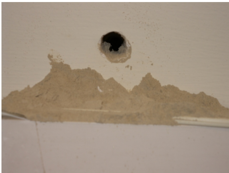
Forat de 36cm de profunditat realitzat a la façana del carrer Bisbe Messeguer. Es confirma que està formada per un sol full i, tot i que la pols semblaria de pedra, no es descarta que es tractés d'un tipus de maó massís de color molt clar
