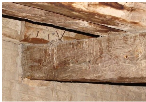
Aspecte humit del cap B del cavall CE"
