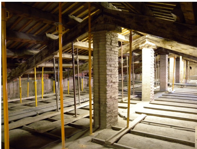
Secció B: Vista general del sotacoberta de l'ala de Rambla Aragó. Es pot observar com el recolzament de la primera tramada és de 19cm de gruix, mentre que la resta són de 38cm
