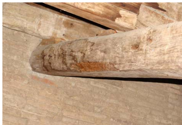
Aspecte humit i atac de corc al cap B del cavall CE''
