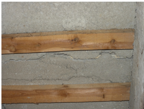
Panells esquarterats seguint la direcció dels llistons de fusta del seu interior
