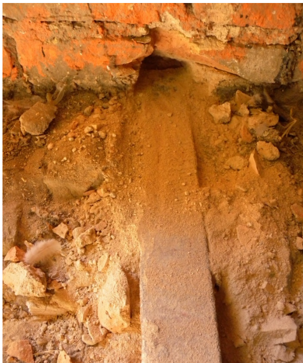
Recolzament del perfil del tram sota coberta inclinada sobre mur de pedra. Sobre el mur, s'aixeca una bancada de maó massís
