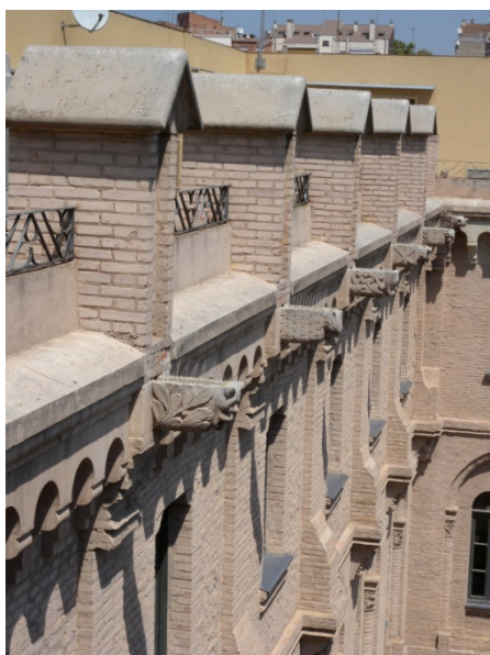
Claustre al costat del carrer Ramon i Cajal. Destaquen les gàrgoles que indiquen el pendent original de la terrassa. També es pot observar com tant la cara exterior de la façana com els pinacles entre les baranes són de maó massís.
