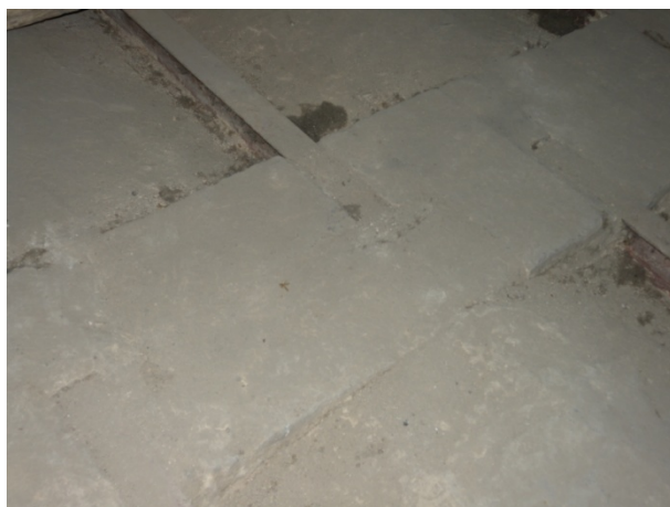
Secció B: Recolzament de les biguetes sobre el mur central, que oscil·la entre els 6 i els 30cm.
