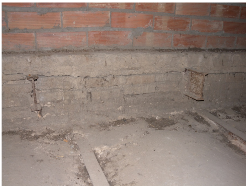
Secció A: Vista del cap de les biguetes de la terrassa del claustre, situades uns 30cm per sobre del forjat de sotacoberta. Sobre els perfils s'identifiquen diverses capes de rasilla que podrien haver format l'acabat original de la terrassa abans de la col·locació del panot.
