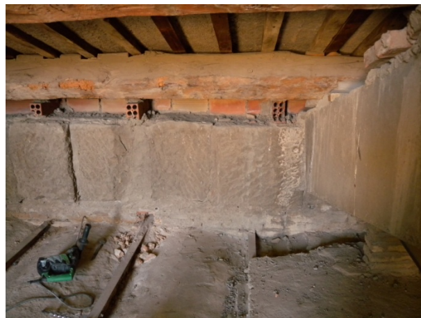
Secció A: Recolzament del forjat i vista interior de la façana en el tram de sotacoberta
