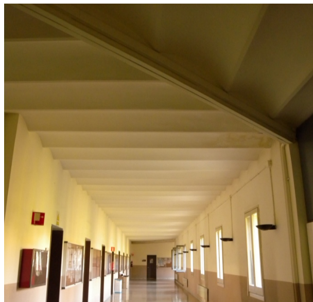
Secció B2 (ala dreta): Vista del forjat de biguetes metàl·liques i revoltons, que sembla ser completament horitzontal
