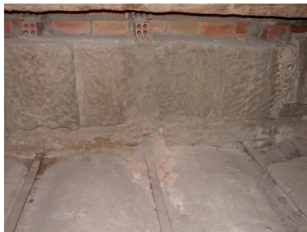
Forjat de sotacoberta, format per biguetes metàl·liques de 180mm de cantell i 55mm d'amplada de l'ala. El revoltó és de dues capes de maó de pla, amb una curvatura d'uns 10cm. Durant unes obres de rehabilitació anteriors, per reforçar el recolzament de les biguetes de fusta es van construir uns pilarets recolzats directament sobre el forjat a través d'una capa de 5cm de gruix de morter.
