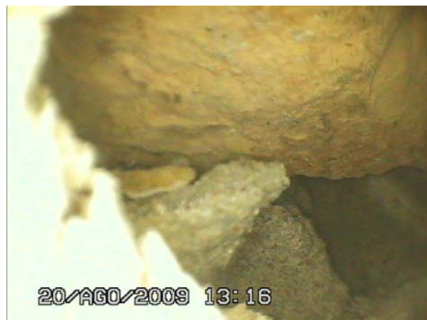
Secció C: A la part inferior, perforació efectuada i per sobre, heterogeneïtat de peces de pedra i maó massís per reomplir l'espai entre els carreus de pedra
