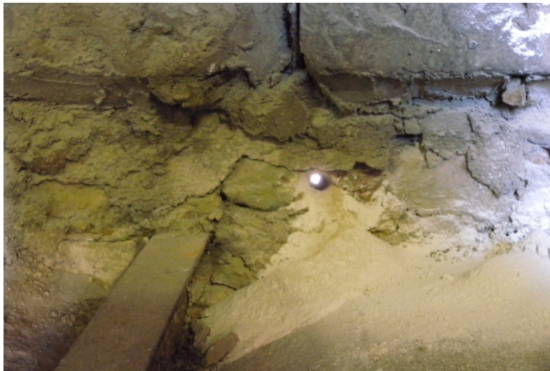
Secció C: Recolzament del forjat en la façana exterior del carrer Bisbe Messeguer, amb la mateixa solució constructiva de la secció A. Es poden observar les dues perforacions efectuades per tal de conèixer els gruixos dels diferents elements.
