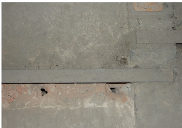
Secció B: Vista del recolzament de les biguetes a la paret de 19cm de gruix. A la perforació del costat es veu un buit i un envà
