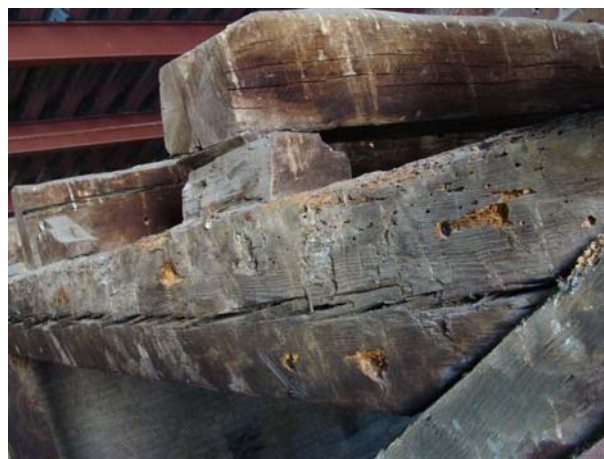
Atac de corc i clivells al cap A del cavall CE''
