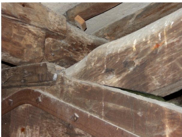
Desajust en el recolzament del cavall CE'' amb la resta de l'encavallada
