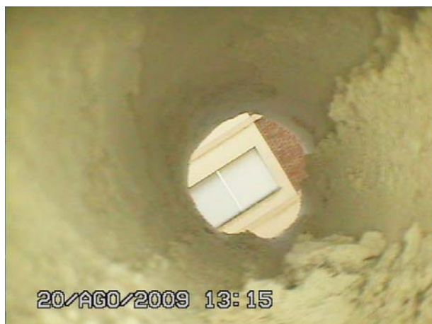
Secció C: Vista amb endoscopi de la part final de la perforació 15cm per sobre del nivell del forjat. El material travessat és pedra, formant la peça inferior de la cornisa
