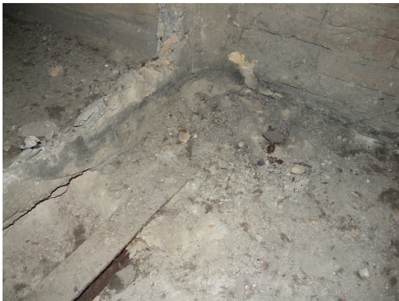
Secció C: recolzament dels perfils de les dues crugies de forjat. Només en aquest punt s'arriba a veure el cap de la bigueta de la crugia de la terrassa
