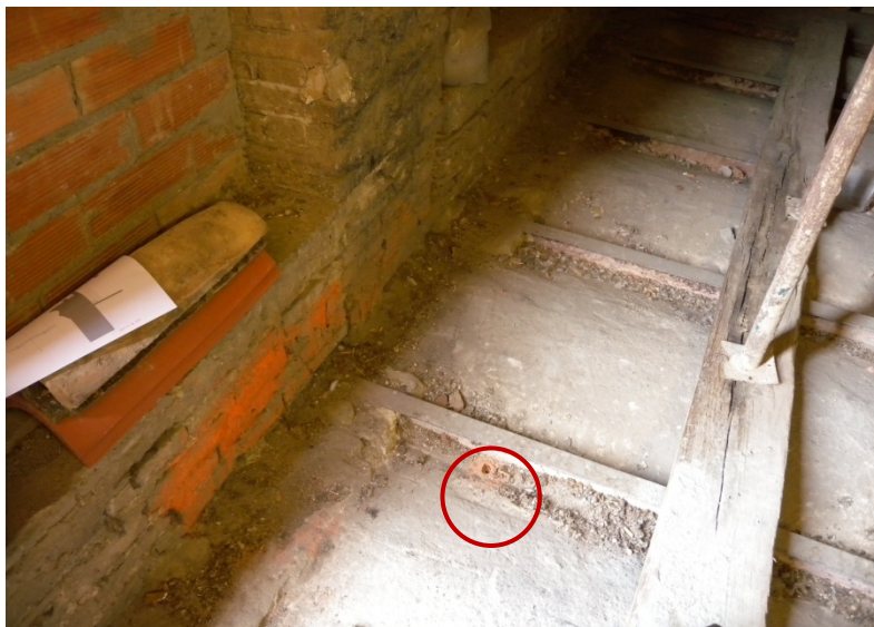
Secció A: Recolzament central de les dues crugies de forjat. Es pot observar el final del mur de pedra, la bancada de maó massís i la part superior de paret de totxana. Encerclat, punt on es va realitzar una cala al forjat per determinar el gruix i composició del revoltó
