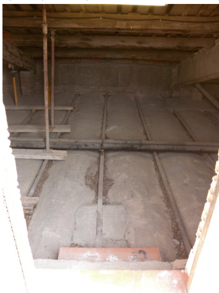
Secció A: Desnivell entre les dues crugies del forjat i identificació dels diferents materials i gruixos de la paret central de la planta sotacoberta
