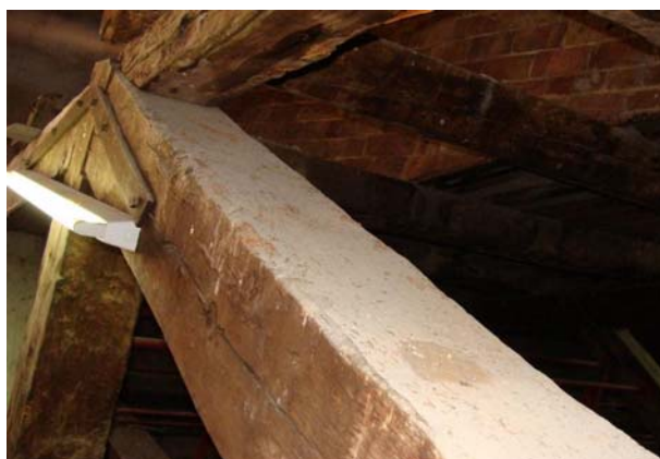
Atac de corc i clivelles al cap B del cavall CE
