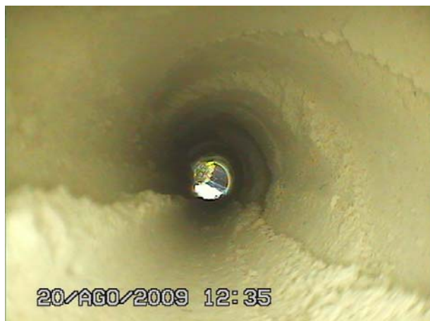
Vista del tram final de la perforació, amb material petri en tot el seu guix
