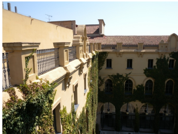
Secció C: Terrassa al voltant del claustre. El forjat és pla per la cara inferior i l'evacuació de les aigües es realitza amb pendents cap a l'interior de l'edifici, tal com es pot intuir per la manca de gàrgoles i buneres prop de la façana del claustre
