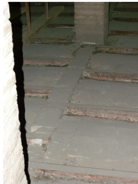
Secció B2 (ala dreta), on la major part dels recolzaments centrals del forjat es realitzen sobre parets de pedra de 19cm de gruix
