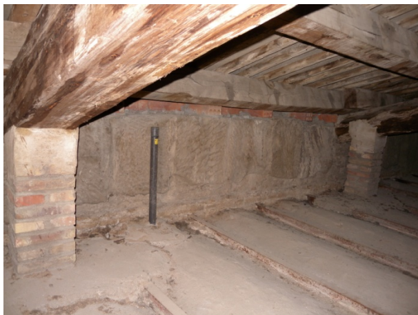
Secció A: Recolzament del forjat i vista interior de la façana en el tram de sotacoberta
