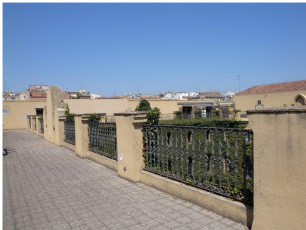
Secció C: Terrassa al voltant del claustre. El forjat és pla per la cara inferior i l'evacuació de les aigües es realitza amb pendents cap a l'interior de l'edifici, tal com es pot intuir per la manca de gàrgoles i buneres prop de la façana del claustre
