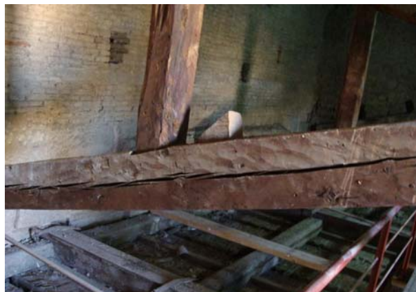
Clivells laterals de 8 centímetres al cavall CE
