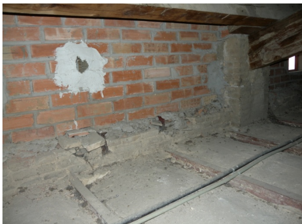
Secció B (ala esquerra): Recolzament de les biguetes del forjat de coberta plana sobre una bancada de maó massís, amb un desnivell de 30cm en relació al forjat interior, tal com succeïa a la secció A
