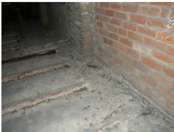
Secció C: Recolzament de les biguetes del forjat sobre un mur de pedra, amb un gruix aproximat de 60cm. El recolzament de la cruïja sotacoberta és d'uns 25cm
