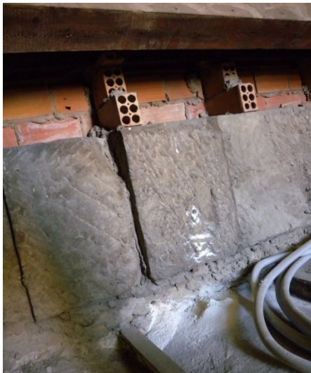
Secció C: Recolzament del forjat en la façana exterior del carrer Bisbe Messeguer, amb la mateixa solució constructiva de la secció A. Es poden observar les dues perforacions efectuades per tal de conèixer els gruixos dels diferents elements.
