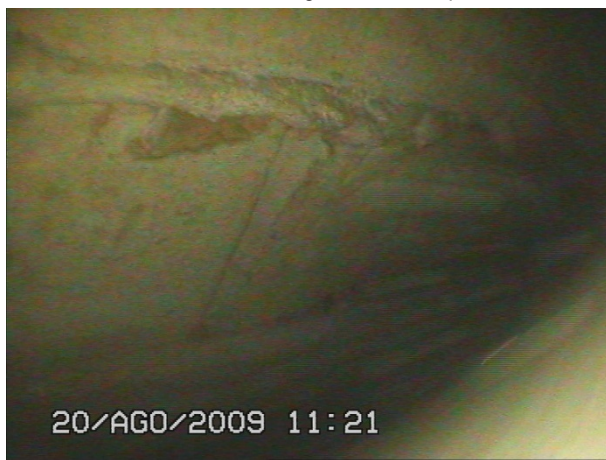
Secció B: Vista amb endoscopi de la cambra d'aire entre la paret de pedra i l'envà
