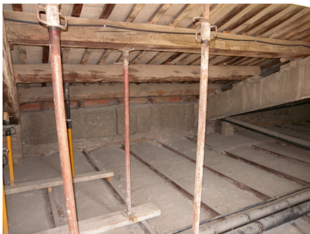
Forjat de sotacoberta, format per biguetes metàl·liques de 180mm de cantell i 55mm d'amplada de l'ala. El revoltó és de dues capes de maó de pla, amb una curvatura d'uns 10cm. Durant unes obres de rehabilitació anteriors, per reforçar el recolzament de les biguetes de fusta es van construir uns pilarets recolzats directament sobre el forjat a través d'una capa de 5cm de gruix de morter.
