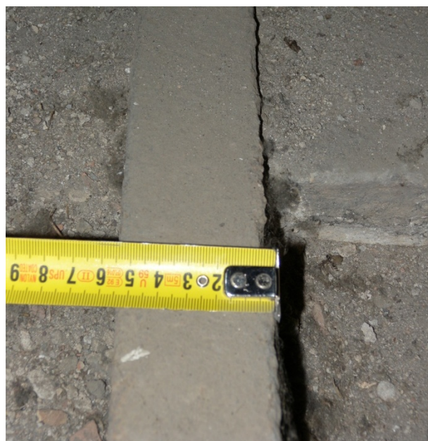
Secció B2 (ala dreta): Perfil del forjat sotacoberta, amb una amplada de l'ala de 55mm.
