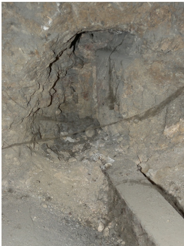
Part posterior de l'ala del carrer Bisbe Messeguer: forats a la façana amb restes que indicarien una antiga presència de perfils metàl·lics sobre els del forjat
