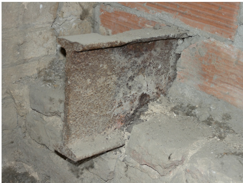
Secció B (ala esquerra): La majoria dels caps de les biguetes del forjat de la coberta plana presenten símptomes d'oxidació i corrosió rellevants, suposant en alguns casos una pèrdua significativa del gruix de l'ànima, que s'ha exfoliat
