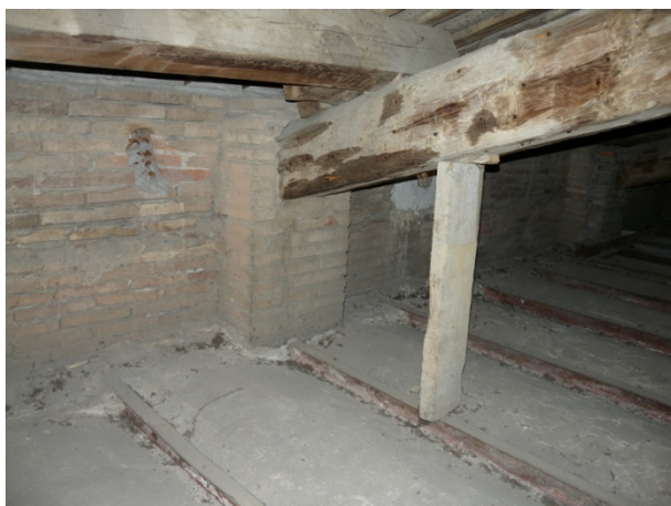
Secció B2 (ala dreta): El recolzament de les biguetes del forjat interior i exterior esta al mateix nivell, recolzades directament sobre mur de pedra
