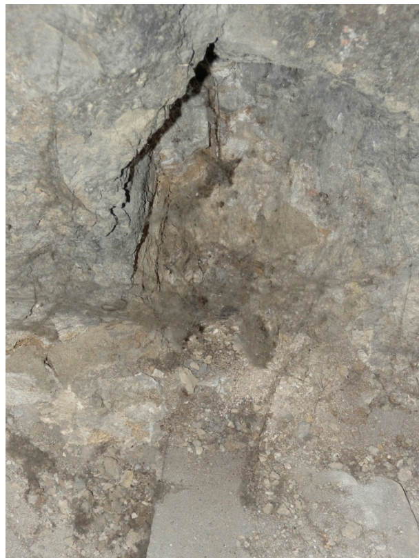
Part posterior de l'ala del carrer Bisbe Messeguer: forats a la façana amb restes que indicarien una antiga presència de perfils metàl·lics sobre els del forjat
