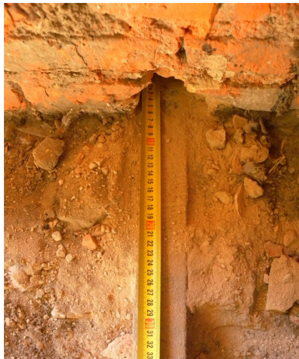
Recolzament del perfil del tram sota coberta inclinada sobre mur de pedra. Sobre el mur, s'aixeca una bancada de maó massís
