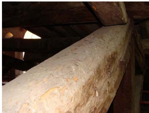
Cavall esquerre de l'encavallada amb atac de corc
