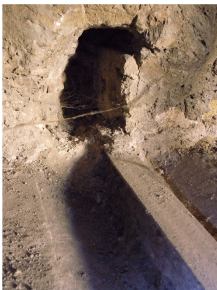
Secció C: Restes d'un antic encastament de perfils a la façana exterior
