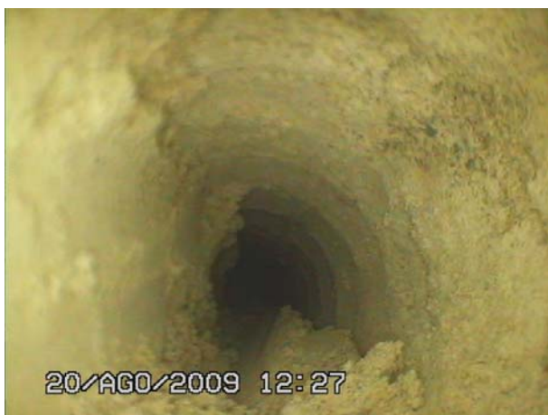
Vista amb l'endoscopi de la transició entre l'obra ceràmica i la pedra
