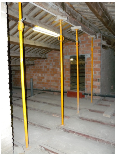
Secció B: Vista general del sotacoberta de l'ala de Rambla Aragó. Es pot observar com el recolzament de la primera tramada és de 19cm de gruix, mentre que la resta són de 38cm
