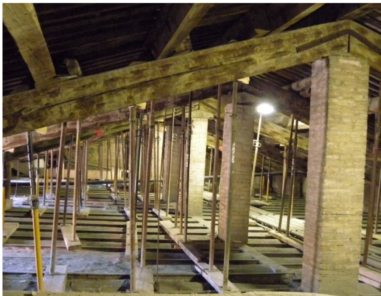
Secció B2 (ala dreta), on la major part dels recolzaments centrals del forjat es realitzen sobre parets de pedra de 19cm de gruix
