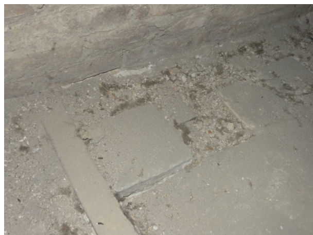
Secció B2 (ala dreta): El recolzament de les biguetes del forjat interior i exterior esta al mateix nivell, recolzades directament sobre mur de pedra
