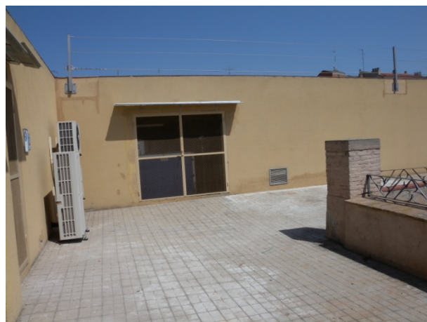
Terrassa del claustre de l'ala de Ramon i Cajal, amb paviment de panot de formigó. Es pot observar a simple vista el pendent cap a l'interior del claustre.
