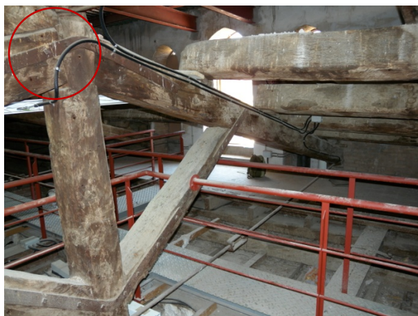
Zona on s'observa un desajust a la unió de les peces de fusta
