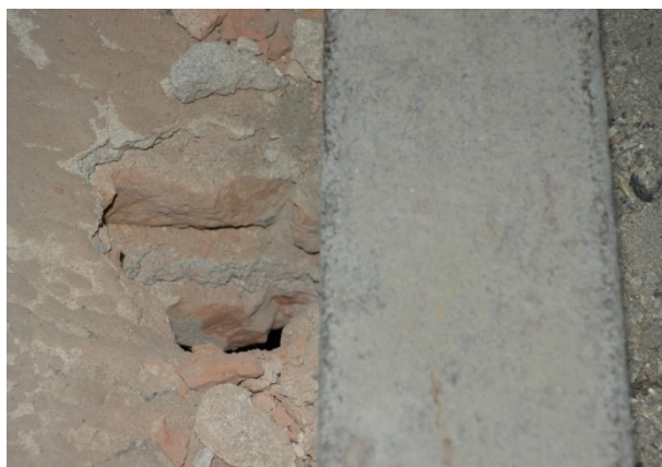
Secció B: Cues capes de maó de pla amb morter conformen el revoltó entre les biguetes metàl·liques
