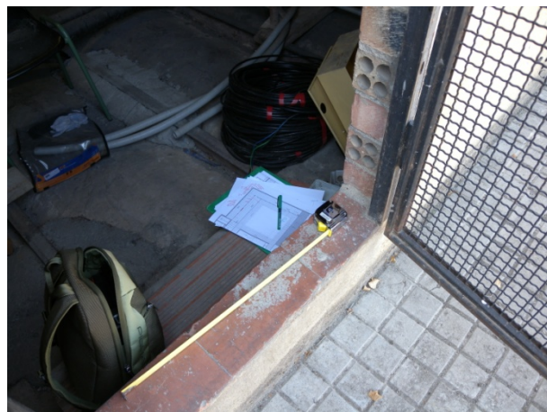
Secció C: Accés a l'ala de Bisbe Messeguer, amb desnivell interior – exterior d'uns 20cm. També s'observen taques d'humitat i una bunera, que indicarien la direcció d'evacuació de les aigües cap a l'interior de l'edifici
