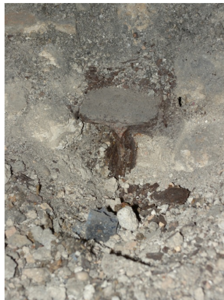
Cap del perfil de la crugia de la terrassa, amb símptomes significatius d'oxidació, corrosió i pèrdua de secció
