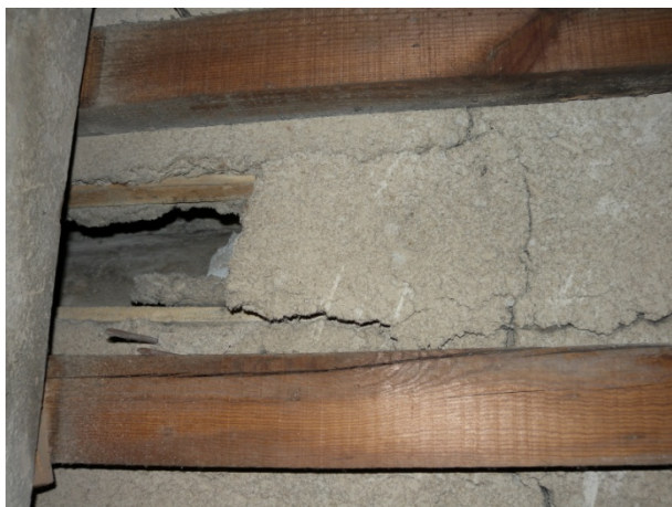
Panell trencat per on es pot veure la part inferior de la teula àrab. La distància entre els llistons de 20x20mm de l'interior del panell és d'uns 10cm, i el gruix total del panell d'uns 5cm.
