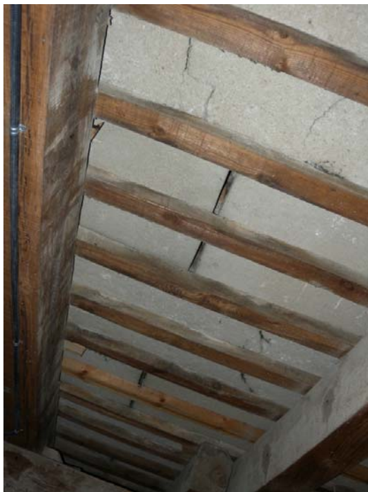
Sistema de suport de les teules de coberta amb un panell de morter alleugerit que es trenca i mou amb facilitat. A totes les ales de coberta inspeccionades de l'edifici es manifesta sovint aquesta patologia.
