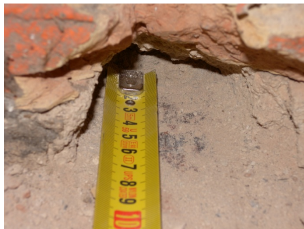
Encastament de 30cm del perfil metàl·lic (23cm sobre paret de pedra i 7cm sota paret de maó massís)
