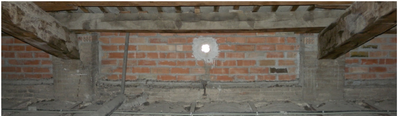
Secció B (ala esquerra): Recolzament de les biguetes del forjat inferior i el de la terrassa exterior a una cota 30cm superior
