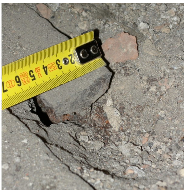
Secció B2 (ala dreta): Perfil del forjat sota la terrassa, amb una amplada de l'ala de 50mm. L'ànima presenta símptomes d'oxidació i corrosió
