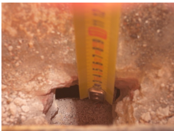
Cala al forjat. La bigueta té 18cm de gruix i el revoltó de maó de pla, uns 4cm.
