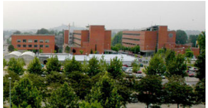
Al campus d'ETSEA s'ubicaran tres de les cinc instal·lacions fotovoltaïques
