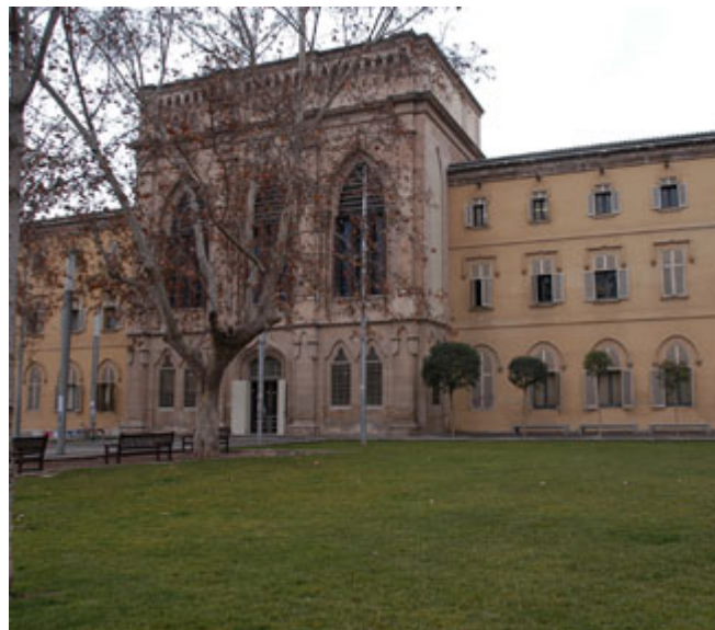
L'edifici del Rectorat acollirà la trobada
