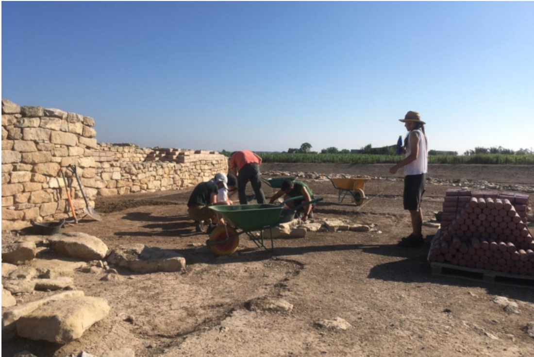
Inici de les excavacions a Vilars / Foto: GIP-UdL
